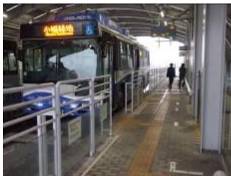
ホーム柵の改修
