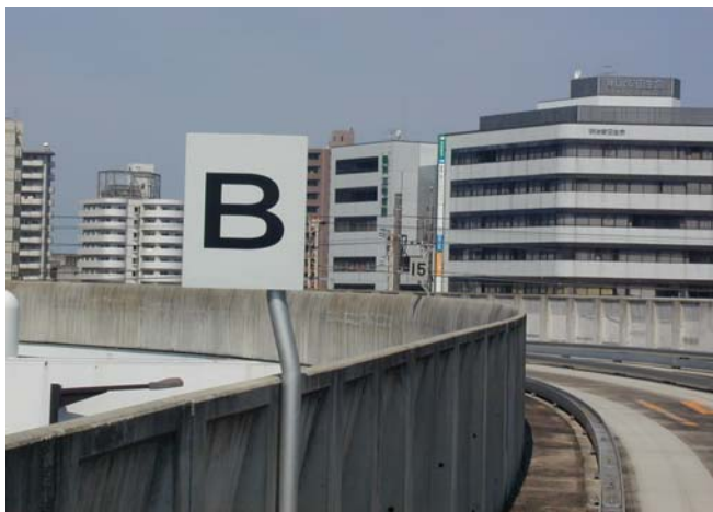
写真-3 B標の設置
