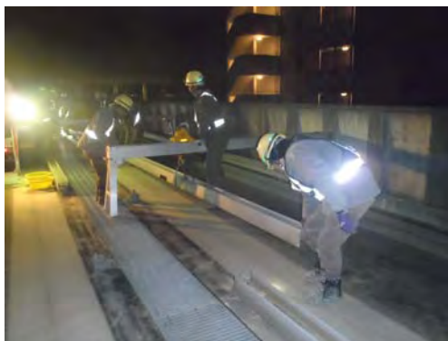
非常渡り線設置訓練
